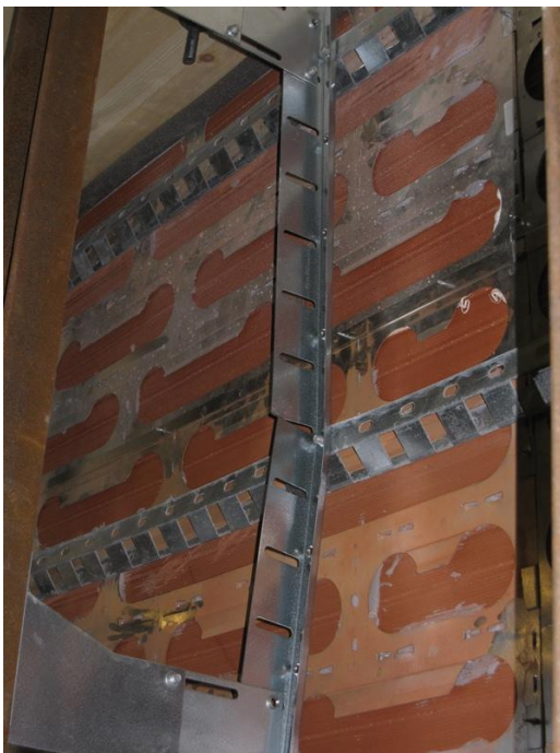
Valokuva 7. Pystykiskon muodonmuutos murron jälkeen.
